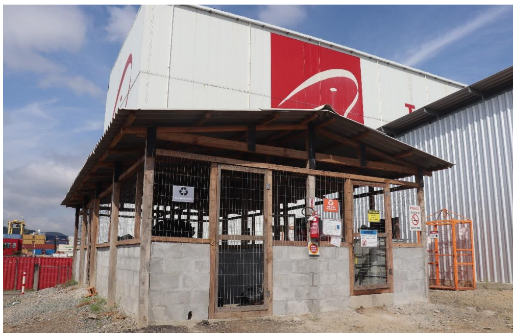
Central de Resíduos localizada no Canteiro de Obras
