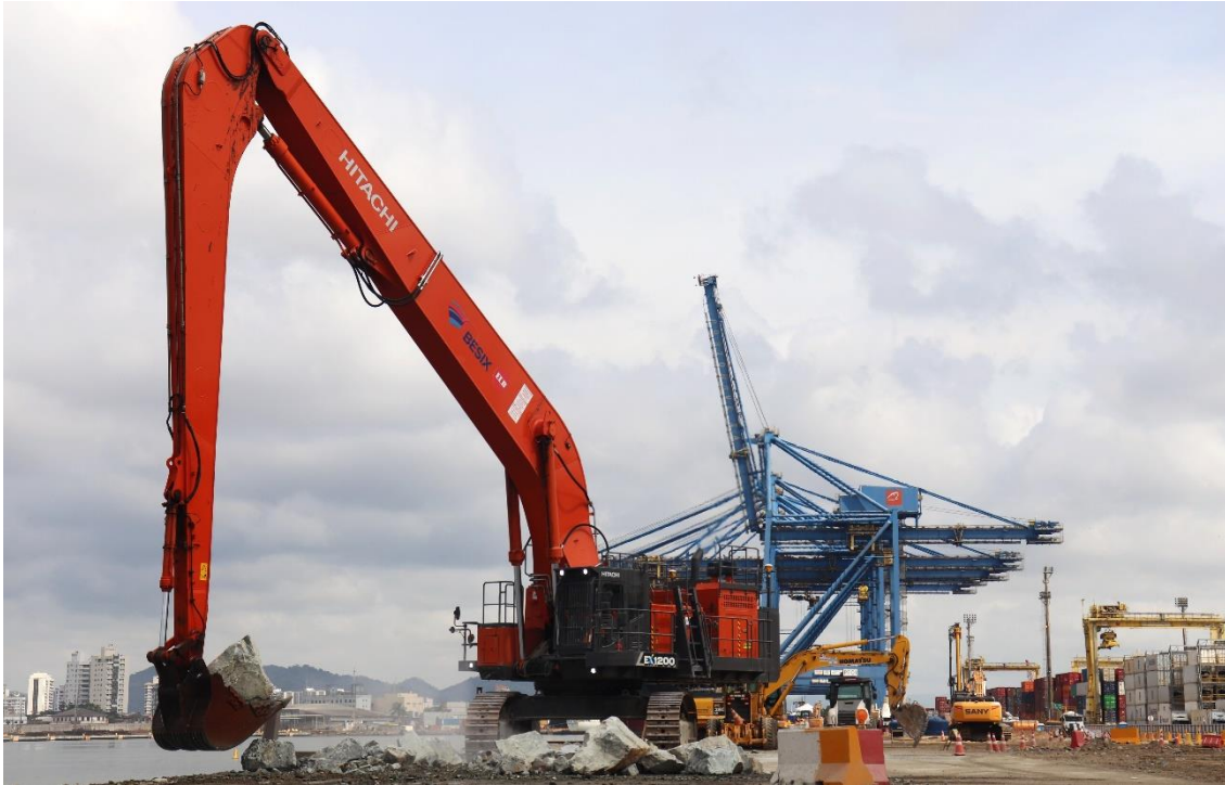
Enrocamento no lado leste
